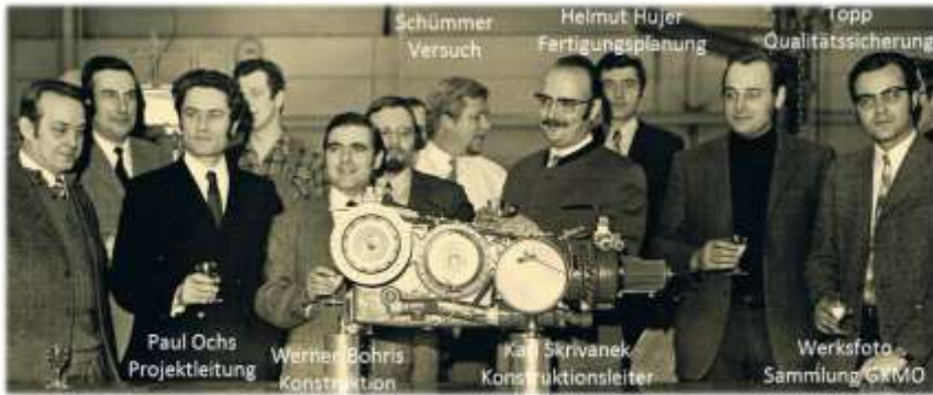
Dezember 1971 - Der erste Steuerbord-Geräteträger ist montiert!
